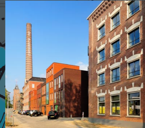
De Blekerij in Boekelo is in de afgelopen jaren getransformeerd naar een terrein voor wonen en werken.
